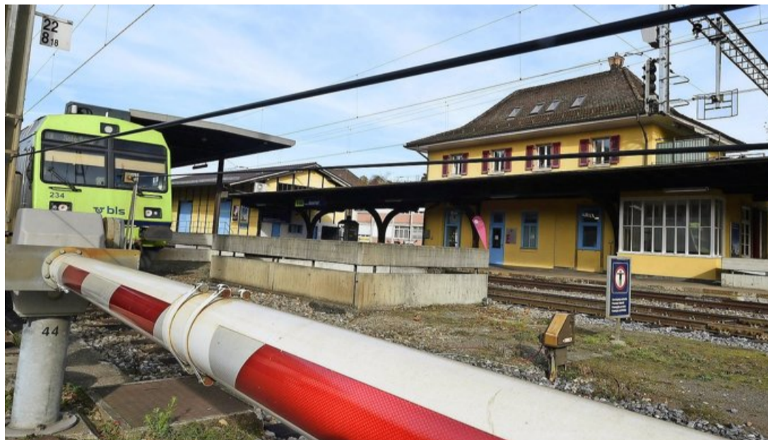
Die Barriere wird bleiben, das alte Bahnhofgebäude wird in wenigen Jahren abgebrochen.
